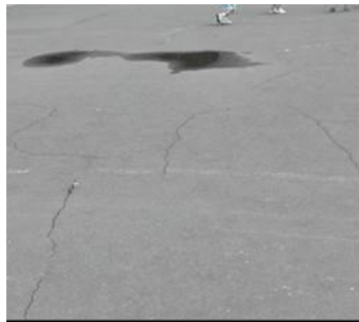
Foto 13: Fisuras longitudinales.
