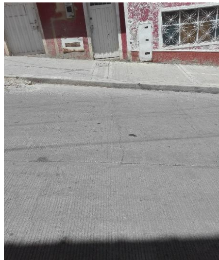
Foto N° 4-5 Rehabilitación Rígido – Presentan fisuras transversales en 16 losas.
