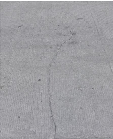
Foto N° 4-5 Rehabilitación Rígido – Presentan fisuras transversales en 16 losas.
