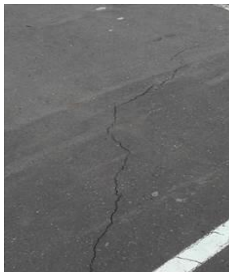
Foto 15: Fisuras longitudinales.
